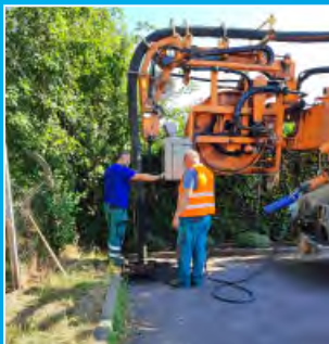
Vyčištění dešťových svodů kanalizace v celé obci
